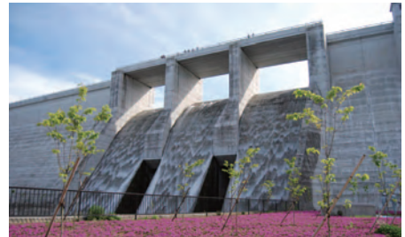
地域の安心・安全を支える治水ダムの建設 (稲葉ダム)
