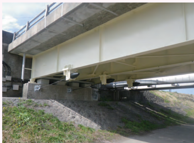
着実な橋梁耐震化の推進 (大分臼杵線 高田橋)
