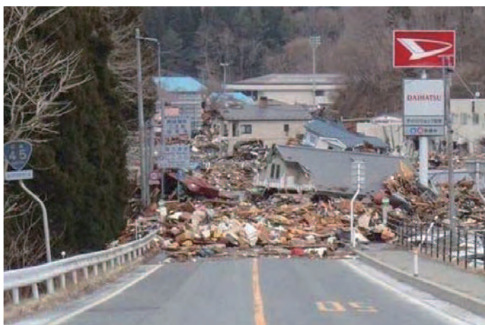
救命・救急、復旧活動に向け迅速な道路啓開が必要
