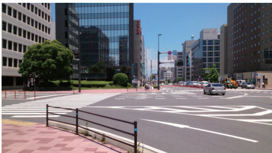
H25年横断歩道橋を撤去し、バリアフリー化と景観向上を実現した昭和通り交差点
