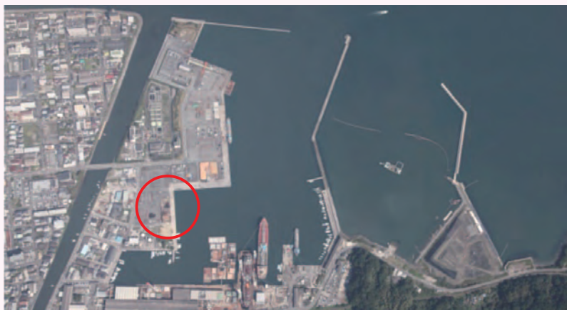
早期対策が必要な港湾岸壁（臼杵港）
