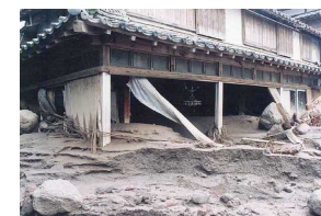
土石流被害 (雲仙普賢岳、島原市提供)
