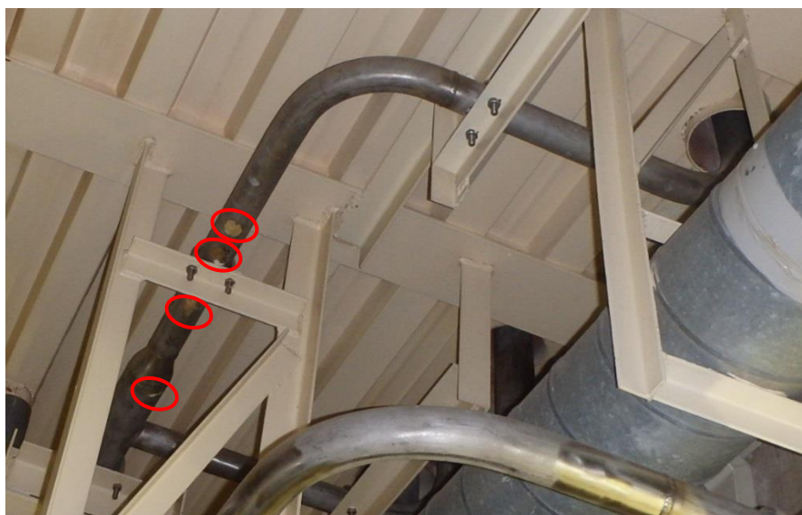
b. サンプルドレン配管 (1箇所)
