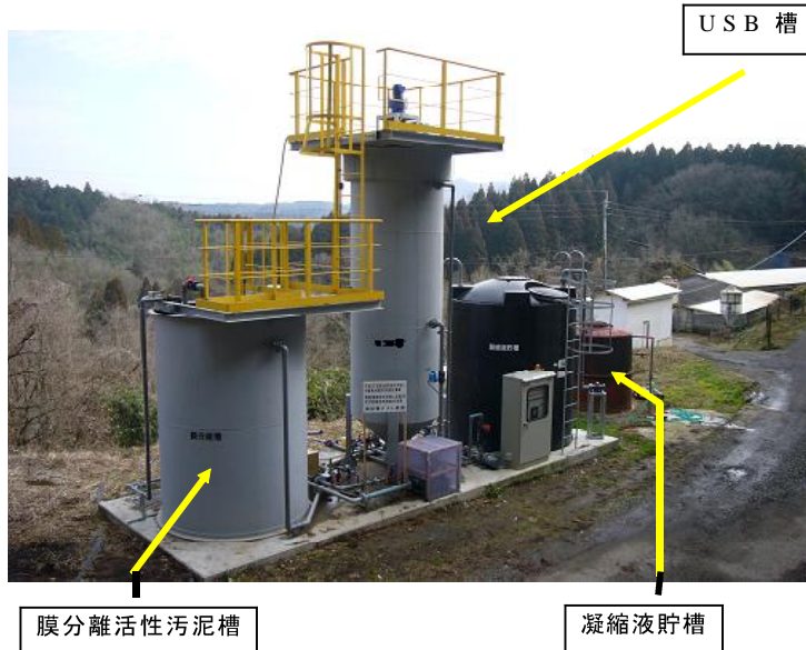
写真1 膜分離槽及び凝縮液利用型USBシステムの概略
