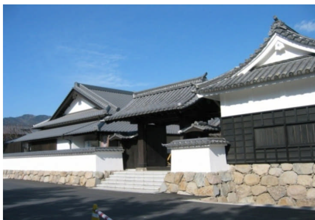
暘谷駅周辺地区の観光交流センター(日出町)
