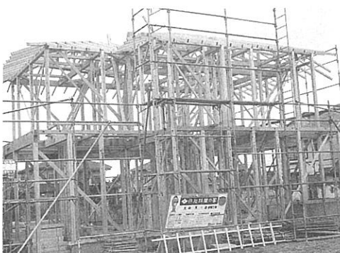
住友林業の住宅建設
