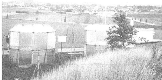
写真-2 火力発電所とオープン・トップチャンバー
