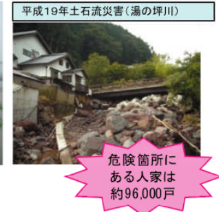
平成19年土石流災害(湯の坪川)
