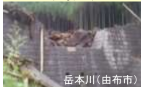
岳本川土石流発生状況(1号ダム)
