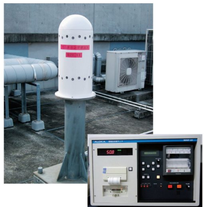
図1 モニタリングポスト検出部(左)測定部(右)
