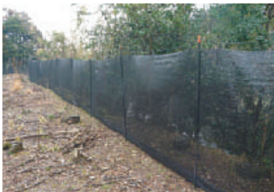
写真-1 遮光ネットの設置例
