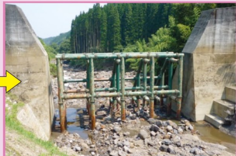
流木撤去工 (H25.7末完了)
