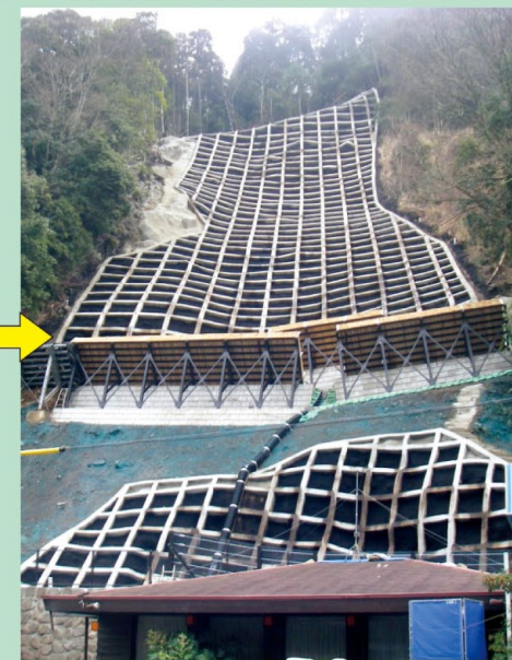
吹付法枠工、鉄筋挿入工 (H26.2末現在)
