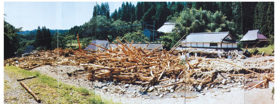
平成5年9月3日の台風13号の被害/松塚川(本耶馬溪町)
