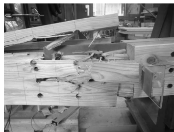
写真-8 割裂破壊
