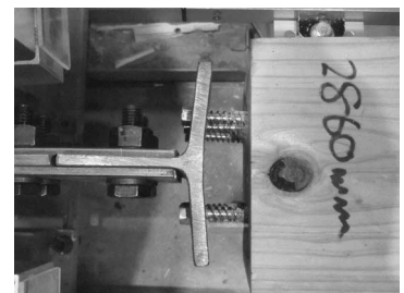
写真-9 ビスの引き抜け
