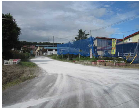
消石灰帯の設置
