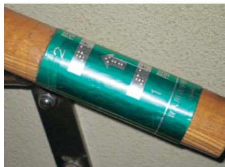
手すりへの点字表示 (県総合社会福祉会館)
