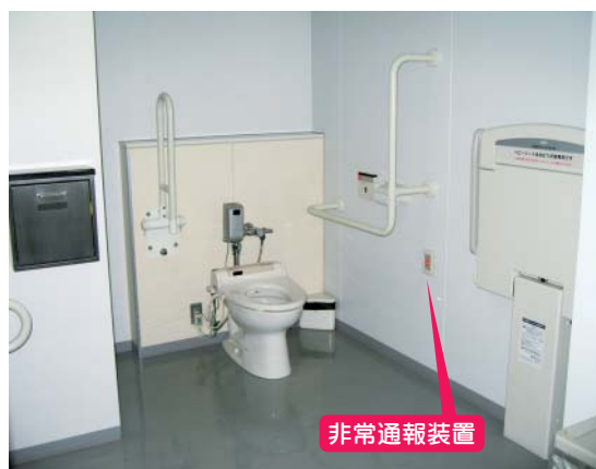
多目的トイレ (大分県消費生活・男女共同参画プラザ「アイネス」)
