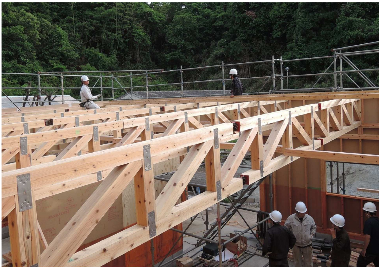
県産スギ大断面構造材に関する研究成果を活かし、建設中の大分大学の倉庫
