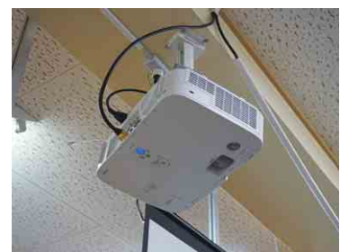
▲ 프로젝タを天井固定式にすると授業開始前の設置・調整作業が省略できる
