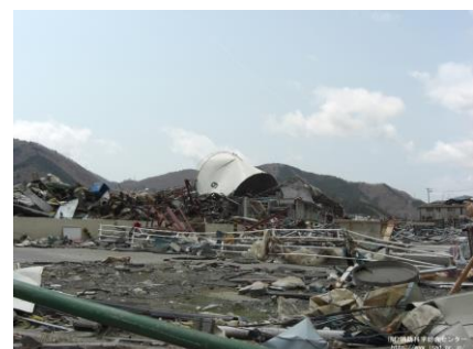
津波の被害を受けたコンビナート 消防科学総合センター災害写真データベースより
