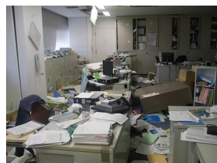
固定していなかった什器の転倒
