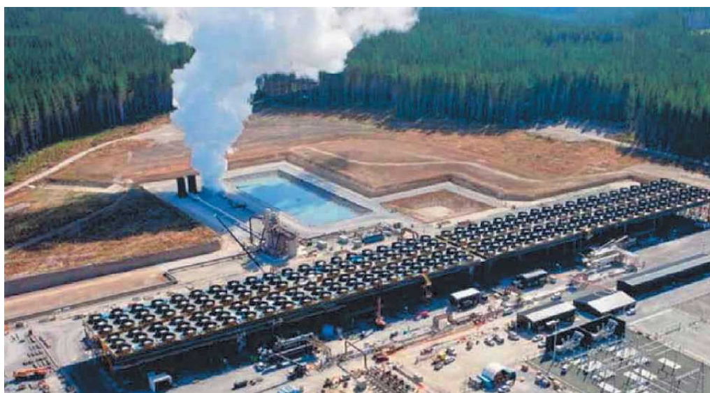
ナタマリキ地熱発電所（熱水全量を還元）
