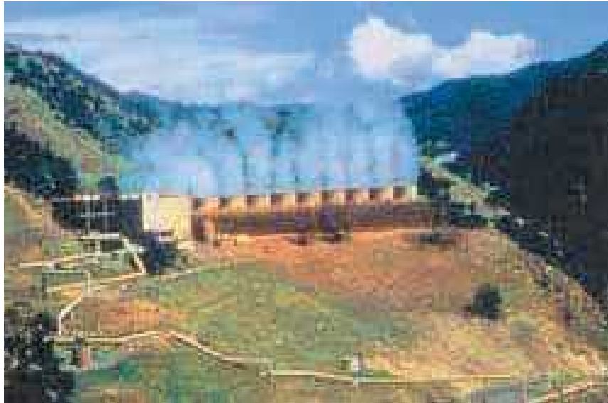
図 4-9 ガイザース地域の地熱発電所の例（カルパイン・ユニット）
