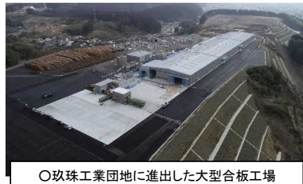
○玖珠工業団地に進出した大型合板工場
