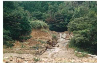
豪雨により決壊したため池
