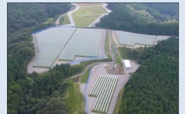
ぶどう団地の整備状況(駅館川地区)
