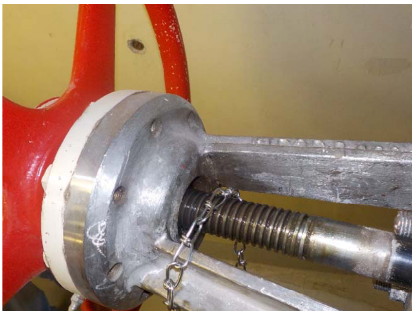
弁操作前の状態
