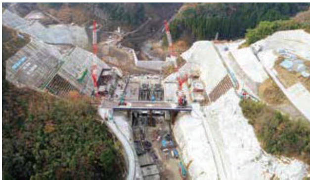
建設中の玉来ダム
