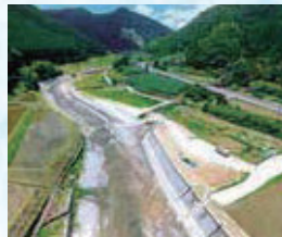
川幅を広げ、護岸工事を行った。
