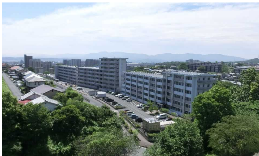
バリアフリー化された住宅（県営 H18～H22 建築）
