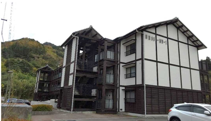
木造3階建公営住宅（県営・津久見市）
