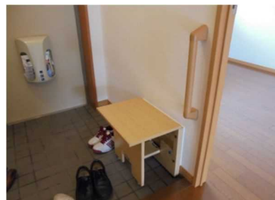
新築時の住戸内（玄関）のバリアフリー
