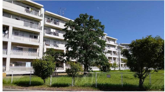
緑豊かな景観の創出（県営・中津市）
