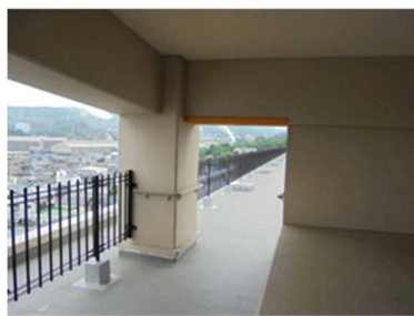
屋上避難スペース
