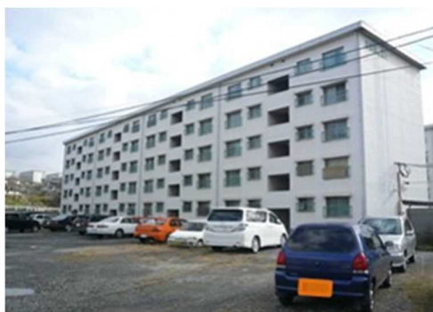
エレベーターのない階段室型住棟
