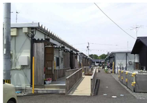
応急仮設住宅のバリアフリー（熊本県）
