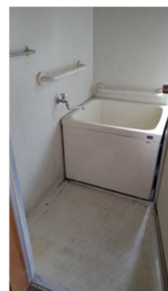
増築時に設置された浴槽
