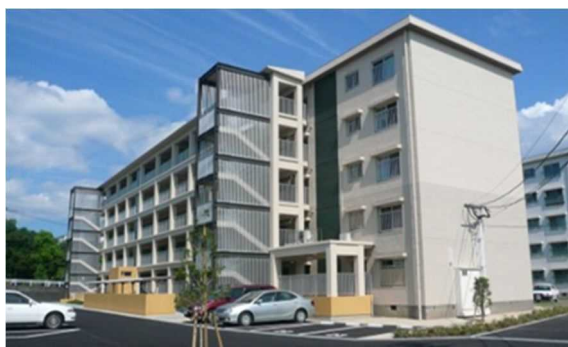
トータルリモデルでの共用廊下とエレベーターの設置
