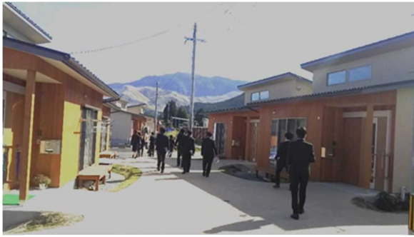
木造の災害公営住宅（熊本県）
