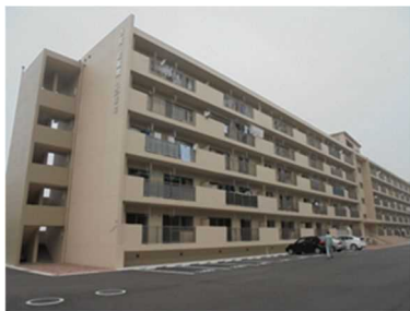
津波避難ビルに指定した市営住宅 （大分市）
