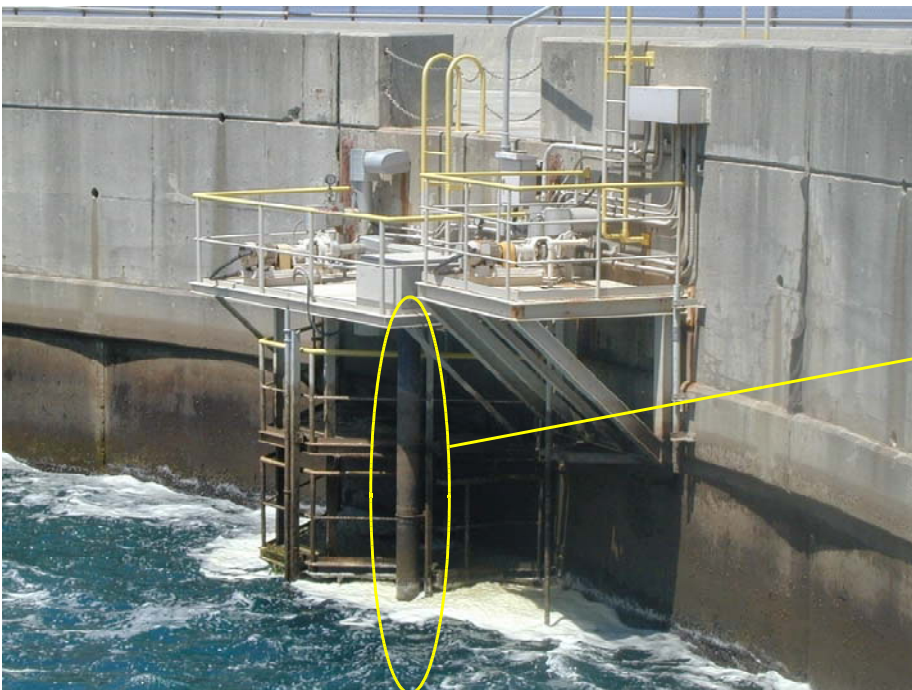
伊方1, 2号機放水口水モニタ設置状況
