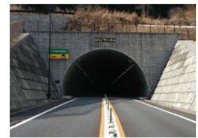
道路トンネル数 596本 (H31.3.31)
