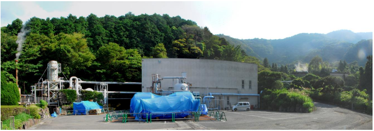
地熱発電所全景
