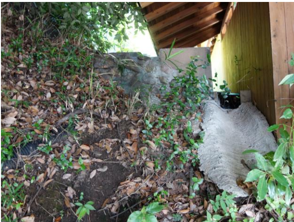
背後斜面に見られる排水対策工
