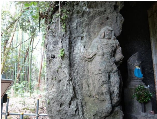
入口向かって左の持国天と岩盤表面の崩落が懸念される亀裂の発達状況
