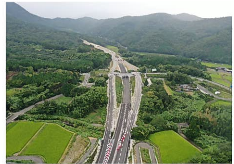
中津日田道路（田口 I C 付近：中津市）
