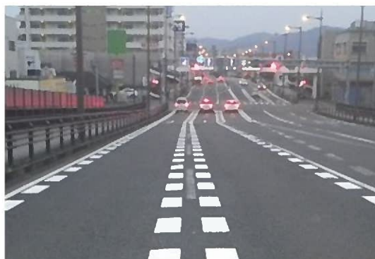
車両減速標示による追突事故防止（国道 210 号：大分市）
