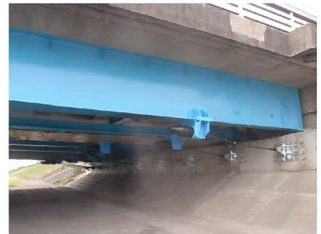
落橋を防ぐ耐震対策 (大分県大分港線弁天大橋：大分市)
