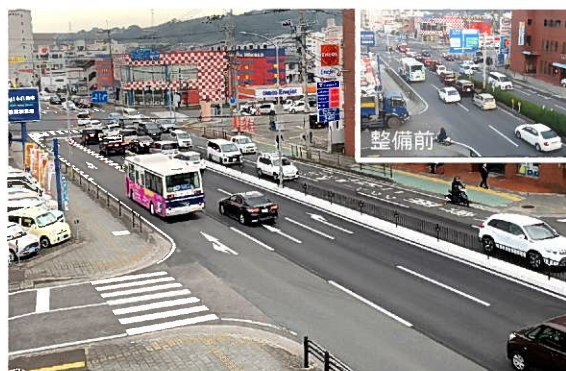
右折レーンの延伸による渋滞対策を実施 (国道197号乗越交差点：大分市)
