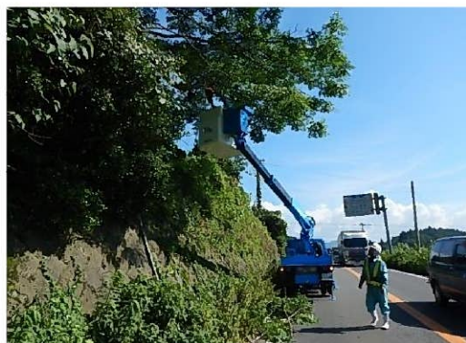
大型車走行時に支障となる枝の伐採
