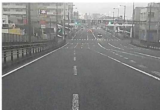
車両減速標示による追突事故防止（国道 210 号：大分市）
