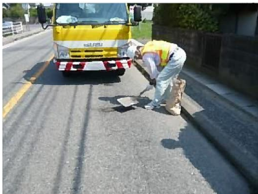
道路パトロール時の簡易補修 (例 損傷の補修)
