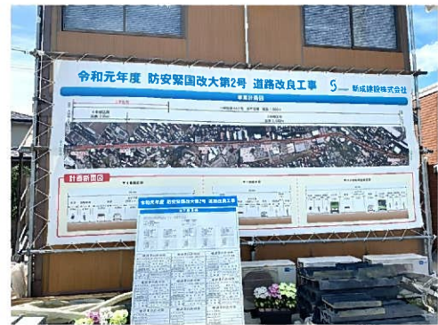
工事現場における完成予想図の掲示 （国道442号：大分市）
