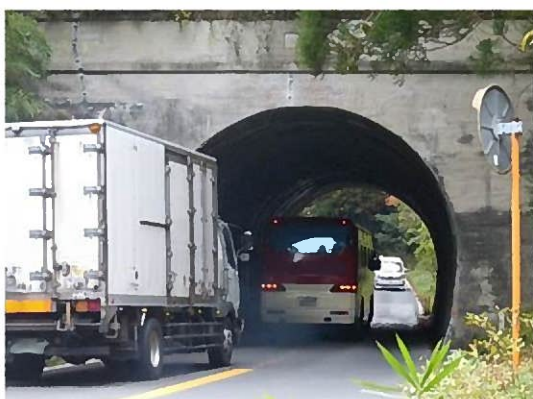
狭隘なトンネルにより通行に支障
