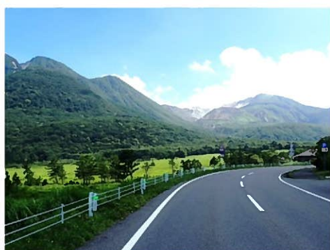
景観に配慮した防護柵への更新 (別府一の宮線：九重町)
