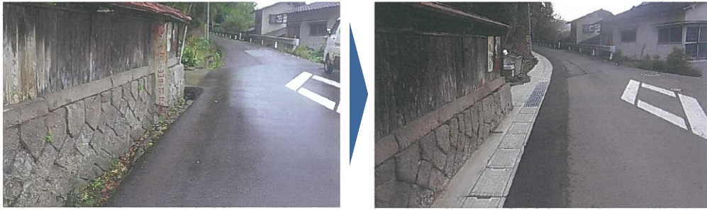
側溝の蓋掛けによる路肩拡幅（日田山国線：日田市）
