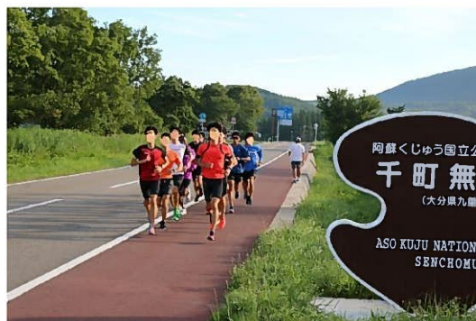
ランナーが走りやすい道路整備(路肩拡幅・カラー舗装) (別府一の宮線：九重町)
