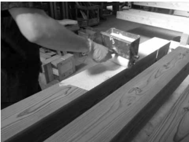
写真-1 接着剤塗布の様子
