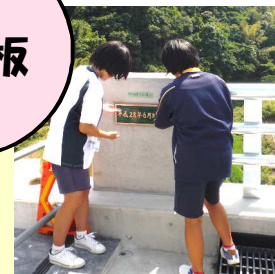
生徒により 橋銘板を設置
