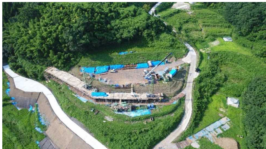
8月3日鋼管杭工(A路線)施工状況(写真位置⑦)
