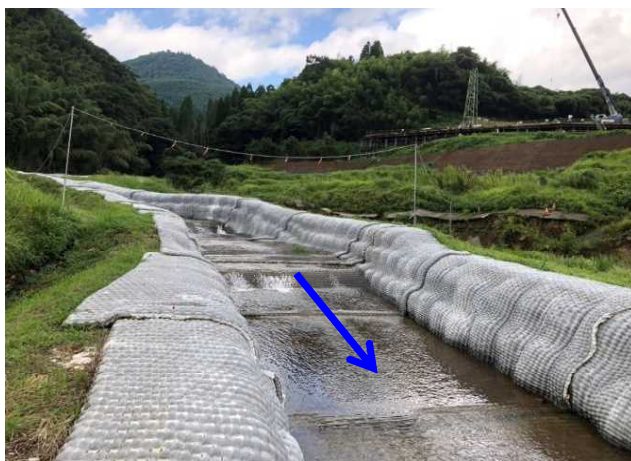
仮排水路工(布製型枠)(写真位置⑦)
