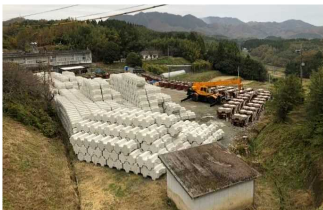
ブロック製作ヤード
