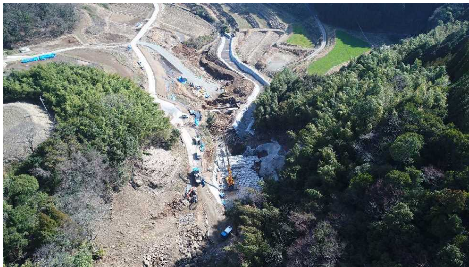
2月20日砂防堰堤、流路工施工状況(写真位置⑦)
