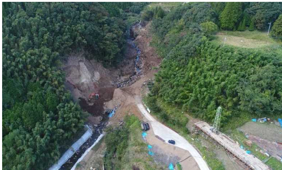
砂防堰堤 土工施工状況(写真位置⑦)
