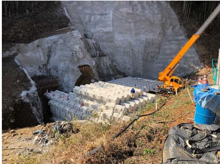
2月20日砂防堰堤ブロック据付状況(写真位置⑦)
