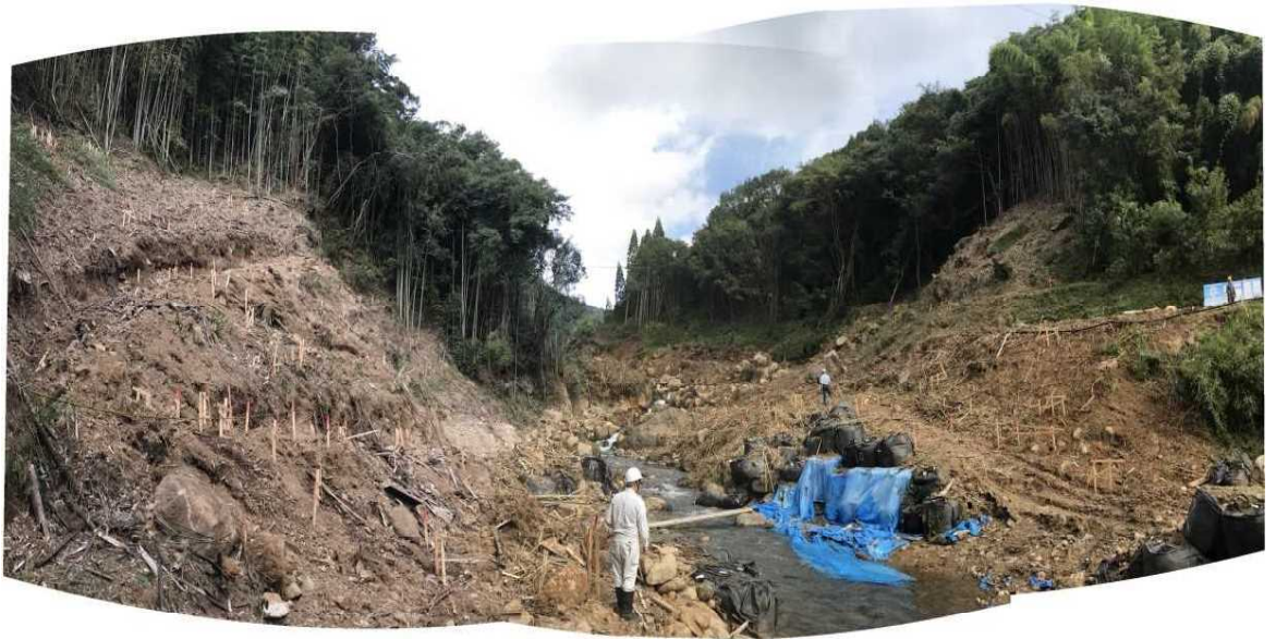
砂防堰堤ダムサイト(写真位置⑦)
