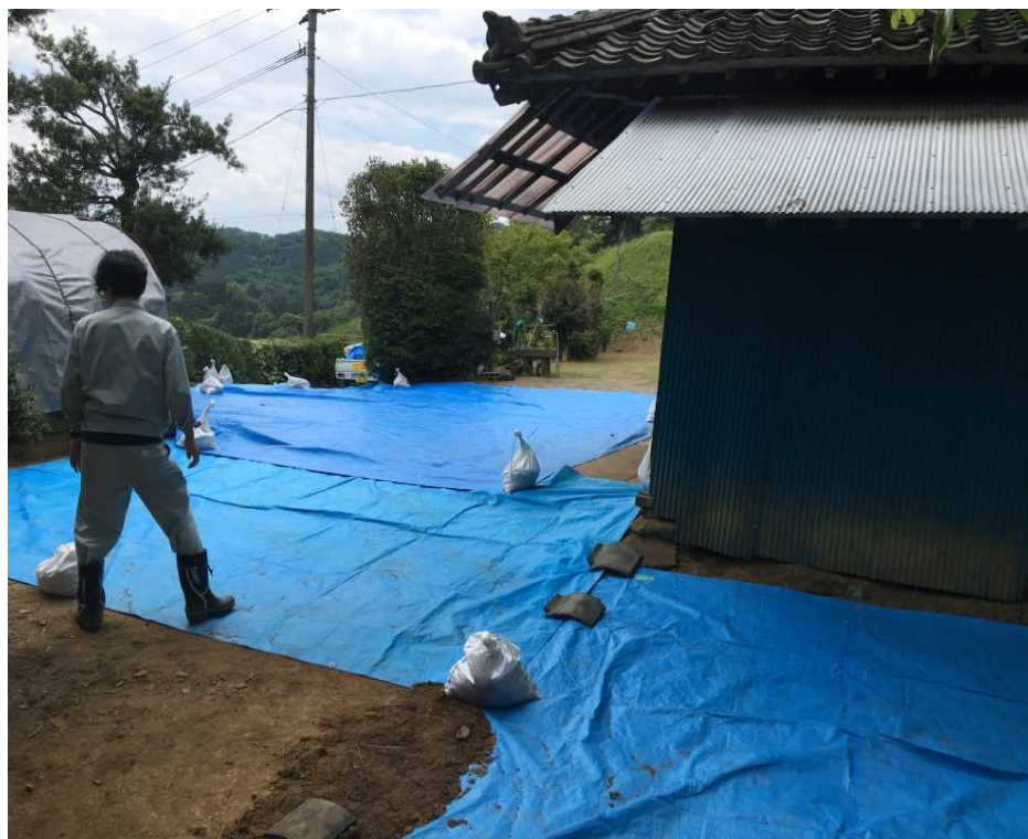
宅地内の亀裂に張られたブルーシート(写真位置④)
