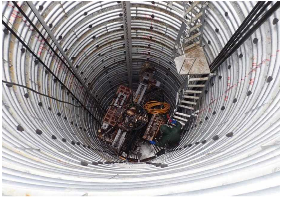
集水井工(集水ボーリング)施工状況
