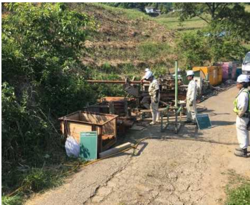
東側の地すべりブロック外からの横ボーリング(写真位置④)
