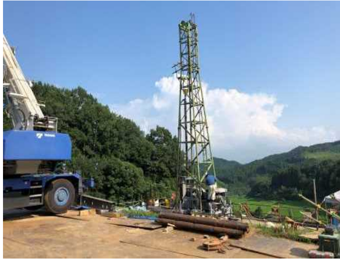
鋼管杭工(A路線)施工状況(写真位置⑦)
