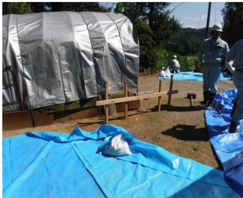
抜き板による観測(5月18日)写真位置④
