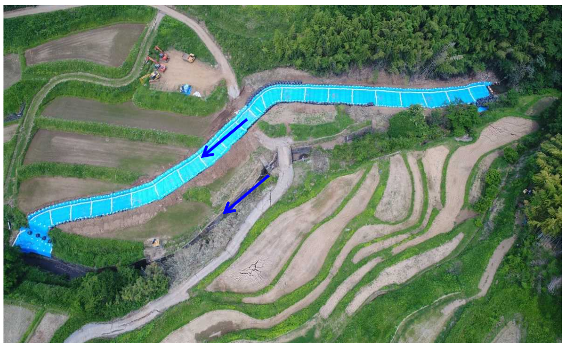
仮排水路(ブルーシート) 6月16日完成(写真位置⑦)
