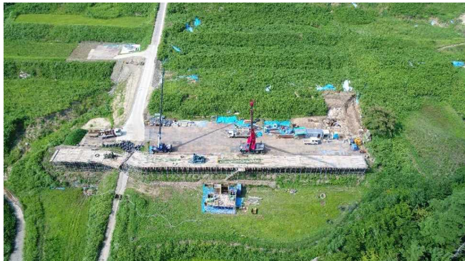
8月3日鋼管杭工(C路線)施工状況(写真位置⑨)
