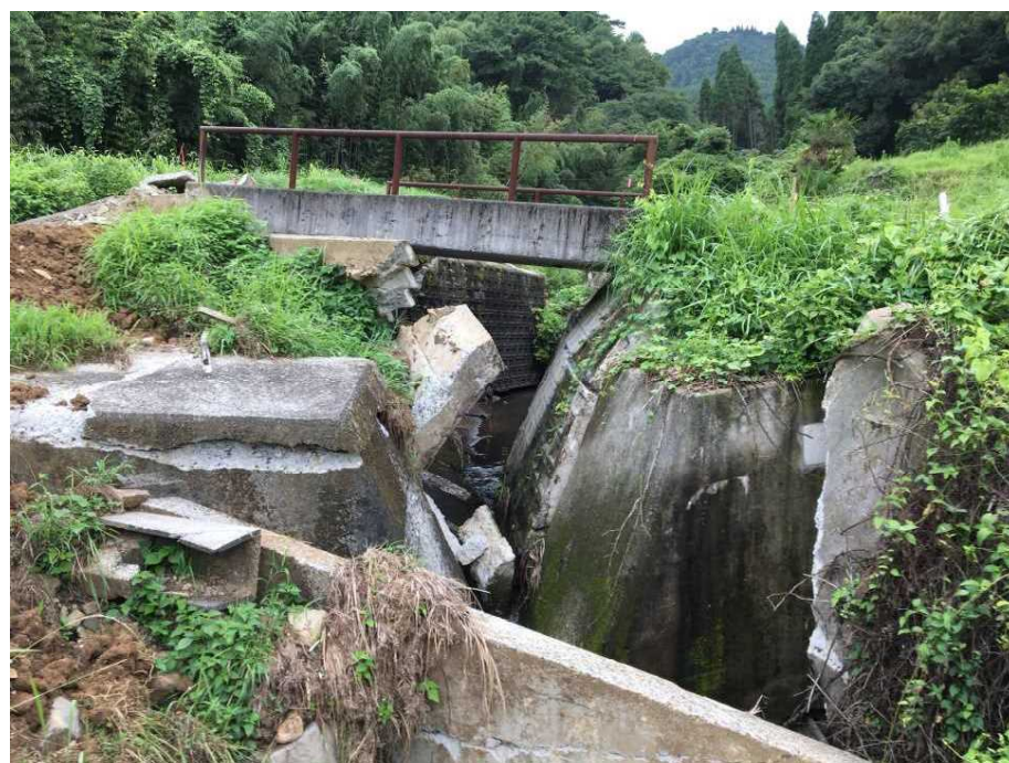
8月3日 平井川床固工(写真位置⑦)
