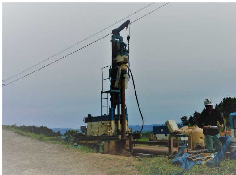
ディープウェル工(No.1)施工状況(写真位置①)
