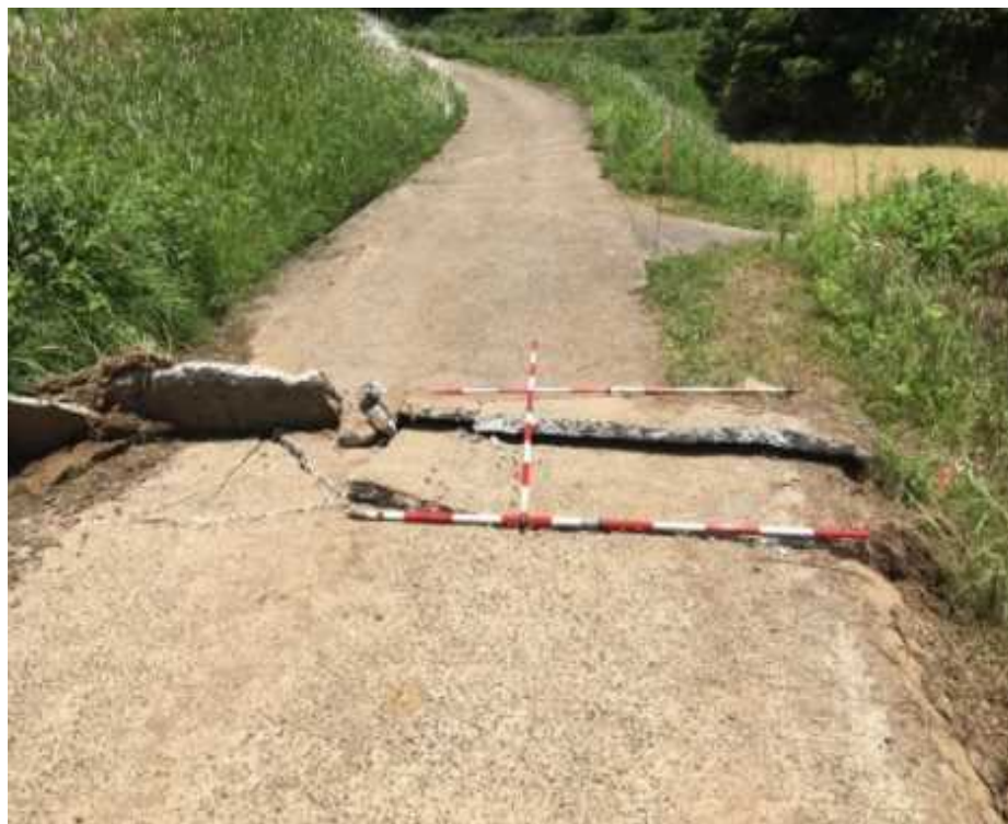
末端部の市道の圧縮(写真位置⑥)
