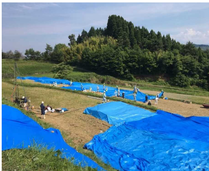
開口亀裂へのブルーシートの設置状況
