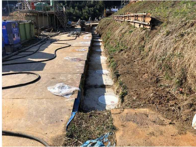
鋼管杭敷設状況(A路線)(写真位置⑦)
