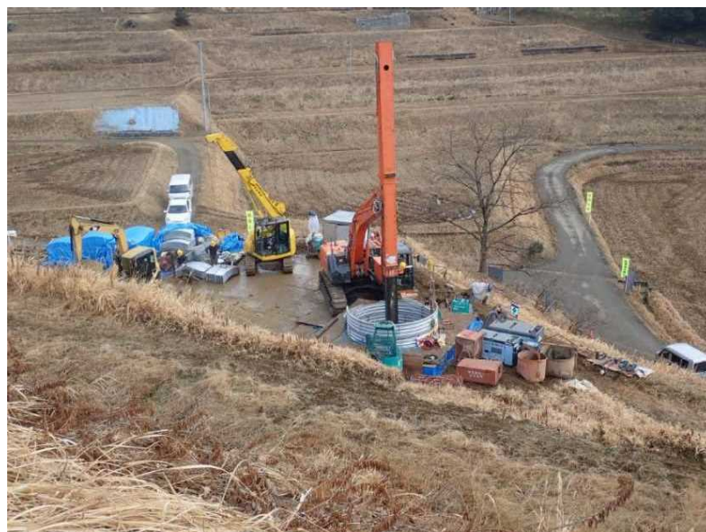
集水井工 (W-6)掘削状況 (写真位置③)
