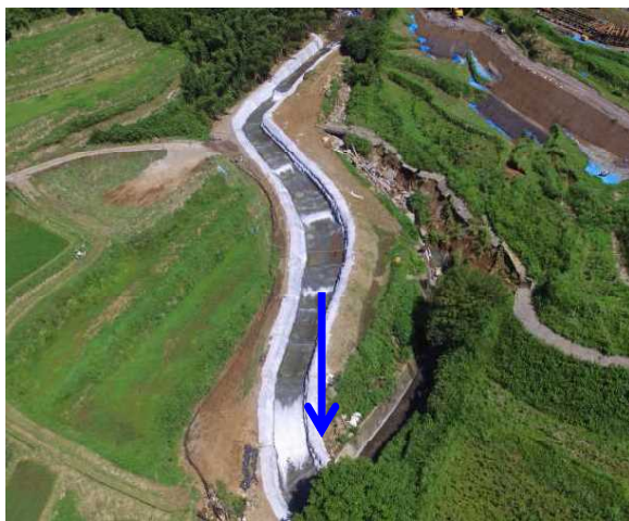
仮排水路工全景(写真位置⑦)
