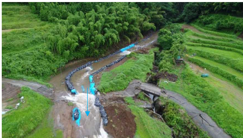
7月6日仮排水路工(写真位置⑦)
