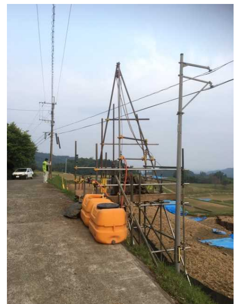
調査ボーリング(BV-18) (写真位置①)
