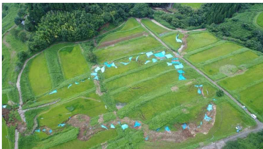
8月1日 頭部のクラックの状況(写真位置⑨～①～②)
