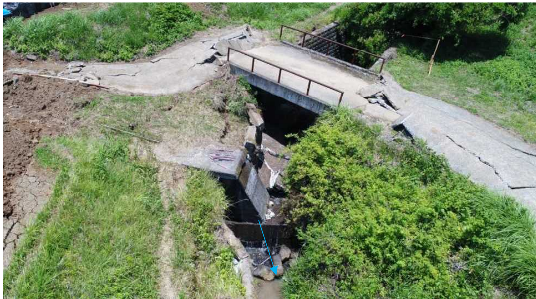
末端部の圧縮 市道橋と平井川流路工(写真位置⑦)
