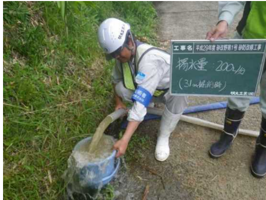
ディープウェルNo.2からの排水状況(写真位置①)
