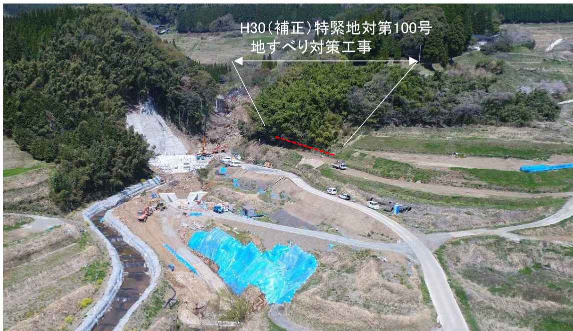
4月8日砂防堰堤、流路工施工状況(写真位置⑦)
