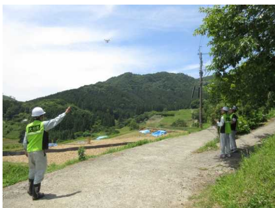
ドローン撮影状況
