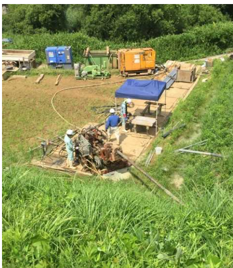
ブロック内からの横ボーリング
