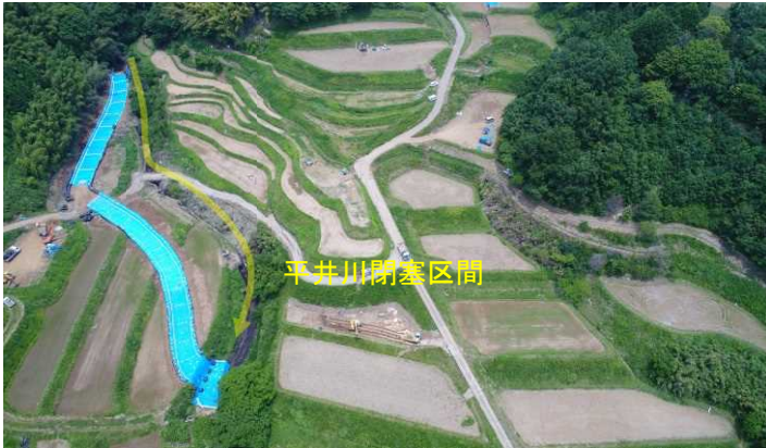
平井川仮排水路工 (H29)
