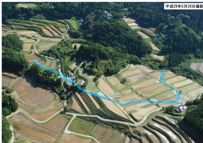
ブルーシート敷設状況
