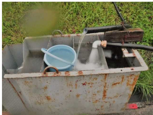
ディープウェルNo.2からの排水状況
