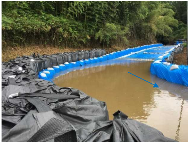
ブルーシートによる仮排水路工 (H29)
