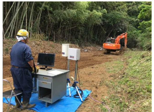
無人化施工による掘削作業
