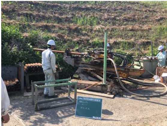
ブロック外からの横ボーリング
