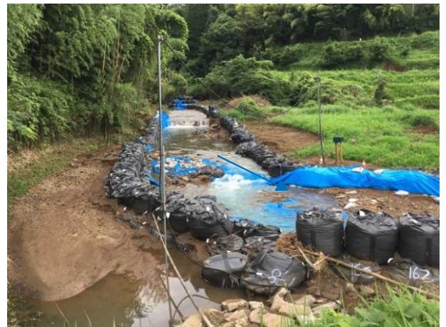
H29.7九州北部豪雨後の仮排水路工
