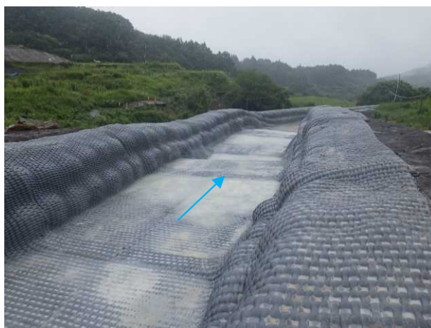
布製型枠による仮排水路工 (H30)
