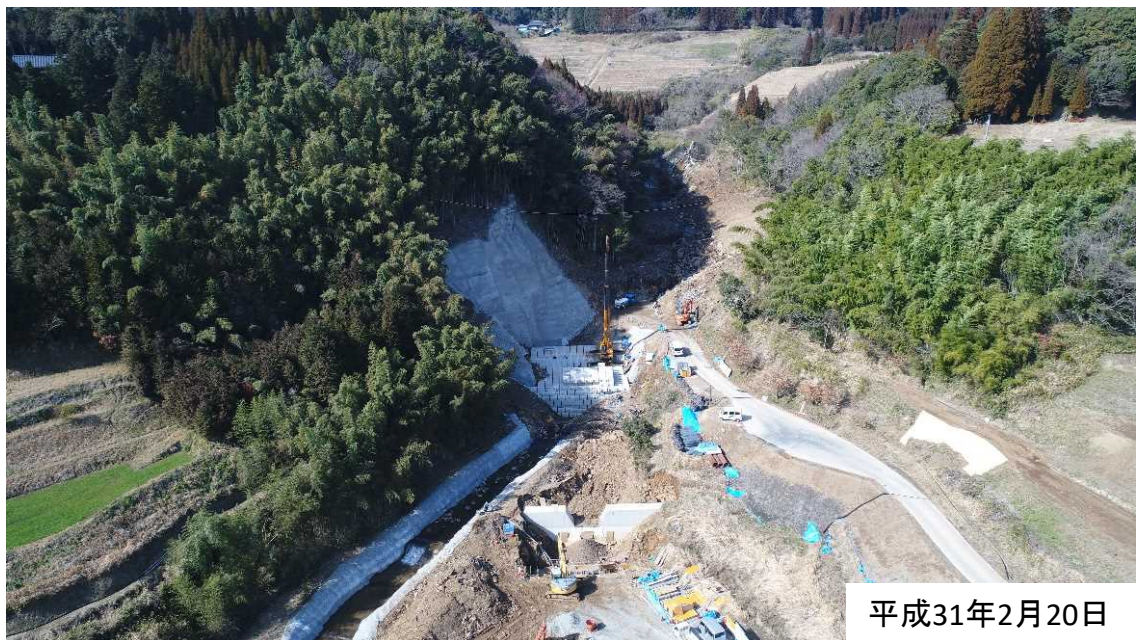
砂防堰堤、流路工災害復旧工事施工状況(写真位置⑦)
