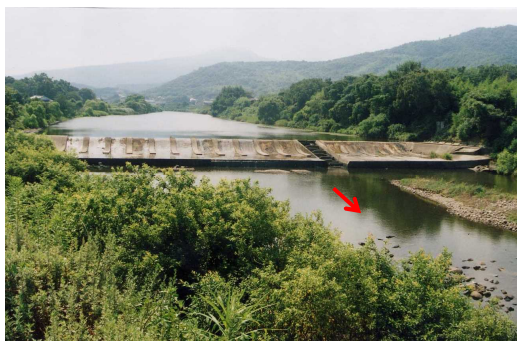
写真 2-3 農業用水を取水している浦田井堰 （桂川：豊後高田市上北）
