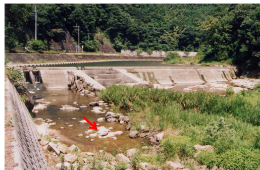
写真 2-4 かんがい期の鍋山井堰下流の流況 （桂川：豊後高田市上野）
