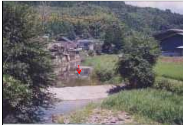
写真2-3 平井川の支川酒井寺川の現況状況 (朝地町戸崎) 平成12年7月
