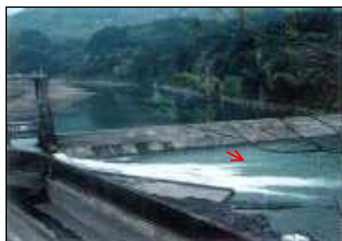
写真2-4 川辺取水堰（三重町川辺）
