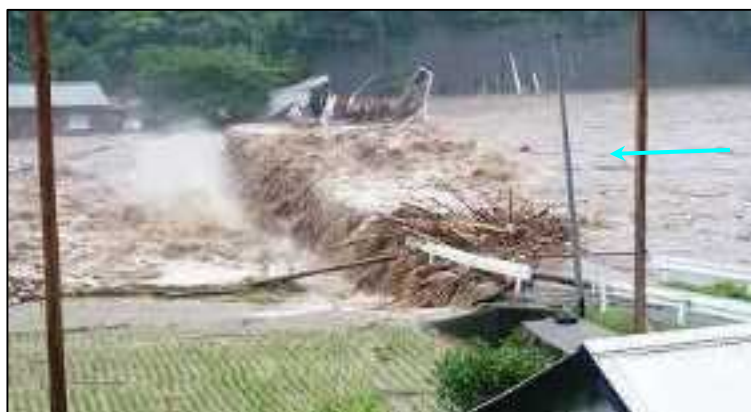
写真 2-1 やながひらはし 柳ヶ平橋(山国川 大島地区) 平成24年7月3日撮影
