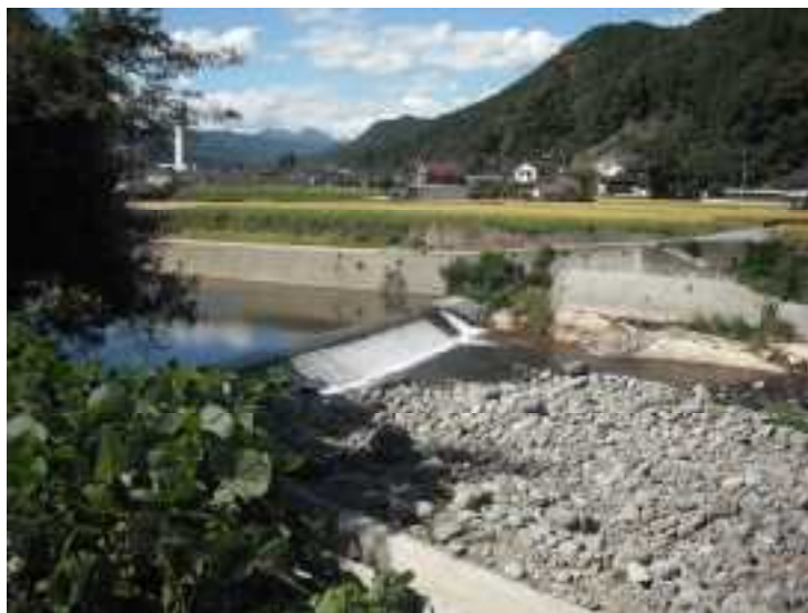
写真 2-4 農業用水を取水している大勢頭首工 おおせ (山国川：平成24年10月撮影)
