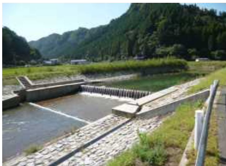
写真 2-5 農業用水を取水している飛瀬井堰 とひせ (金吉川：平成25年9月撮影)
