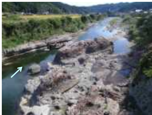
写真 2-14 彦見橋下流部 (露出した奇岩をえぐって形成される淵)
