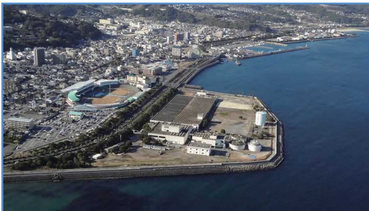
別府市中央浄化センター
