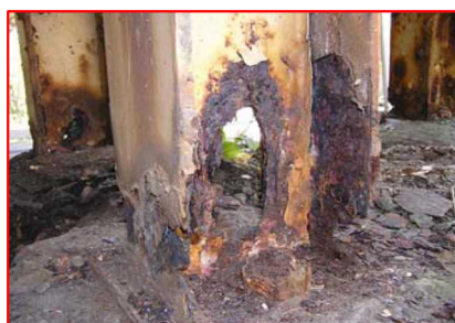
腐食片を取り除いた状態例(下部)
