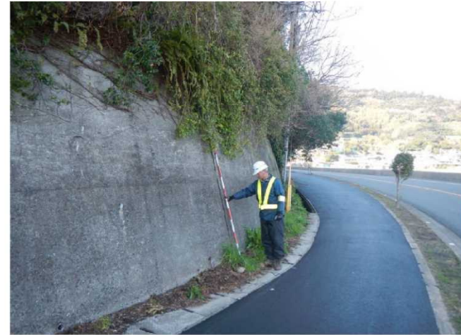
P4 中央付近 コンクリート擁壁目地状況(遠景)
