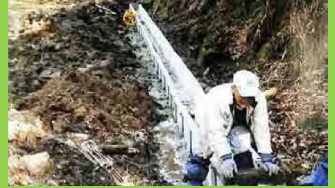
水路の保全作業
