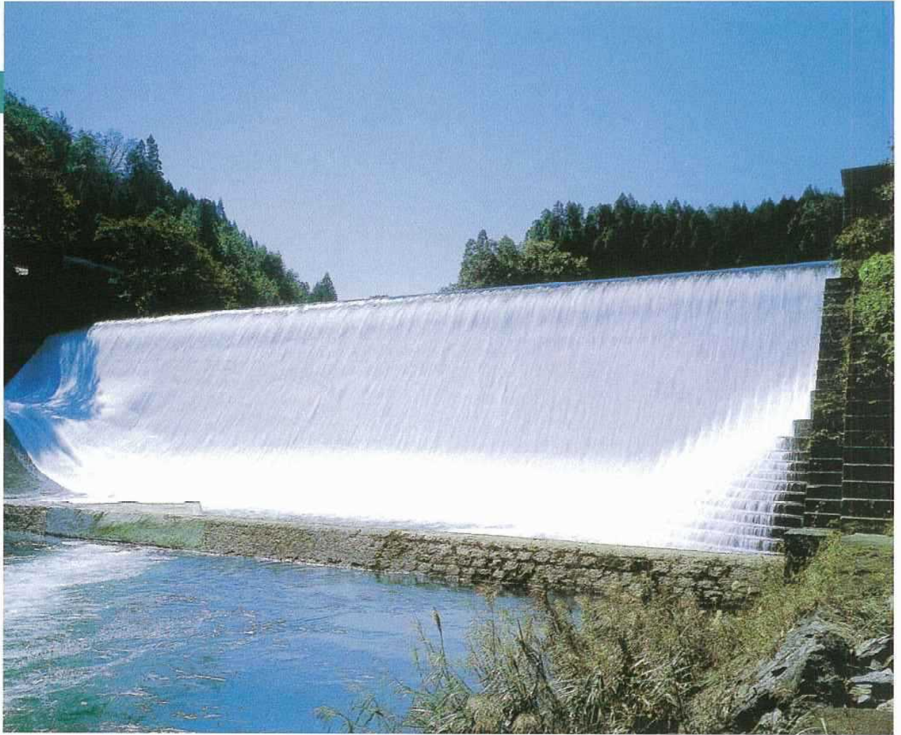
富士緒井路の水源として昭和9年着工、同13年完成した。 「日本一美しいダム」として平成11年に国の重要文化財の指定を受けた。 「粗石コンクリート造り越流式重力ダム」
