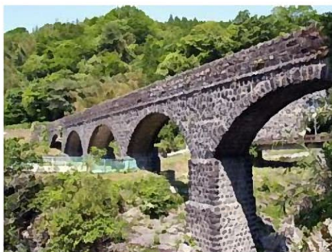
②⑤ 明正井路（めいせいいる）第一拱石橋
