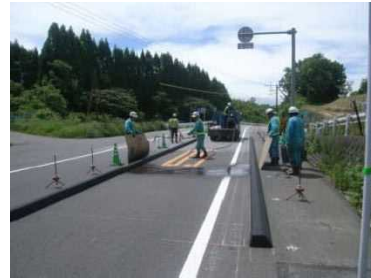
消毒槽設置（6月12日）
