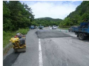
消毒槽設置（6月12日）
