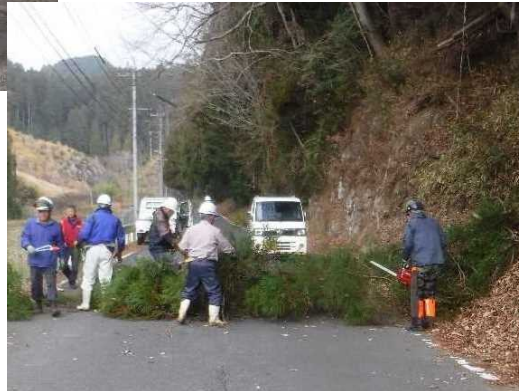
↓ 伐採作業の様子
