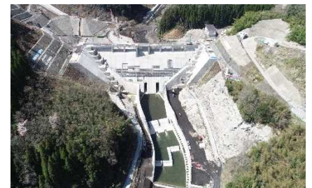
建設が進む玉来ダム
