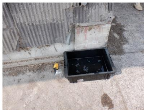
図6：畜舎入口の消毒設備
