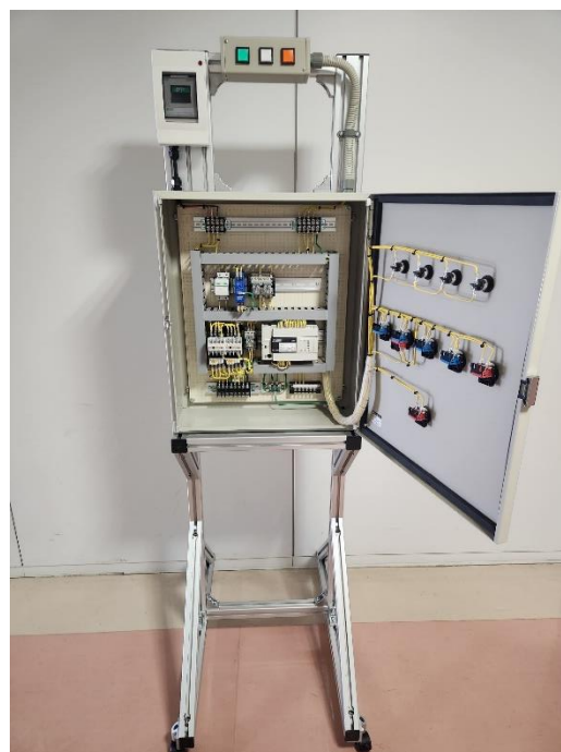
図9 配線した工場電気設備実習装置
