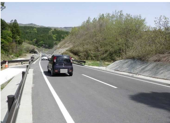
▲ (主) 庄内久住線 (塩手工区) 竹田市直入町大字下田北
