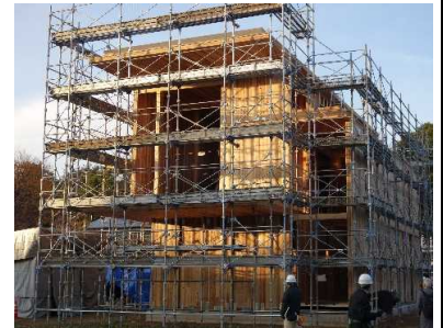
木質材料需要拡大のためのCLTパネルの特質をいかしたCLT実験棟(国立研究開発法人建築研究所)
